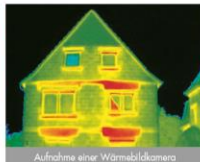
Aufnahme einer Wärmekamera
