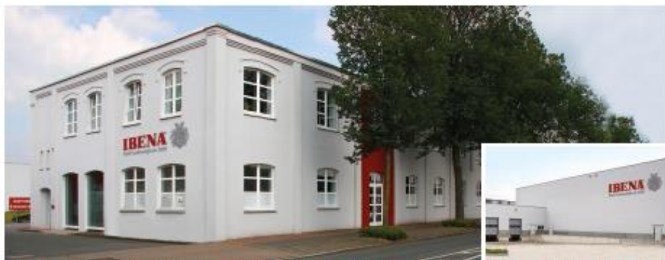
Öko-Bau - Generalunternehmer für die Renovierung des IBENA Gebäudes
