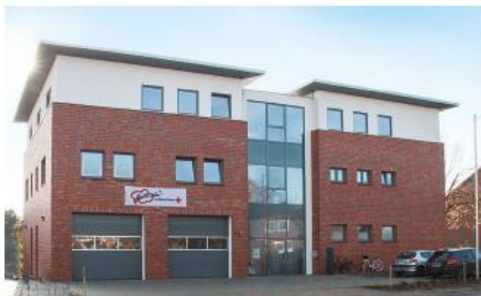
Öko-Bau - Generalunternehmer für das DRK Zentrum in Rhede
