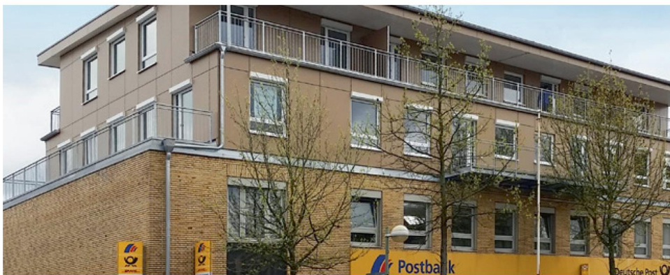
Öko-Bau - Aufstockung mit Trespa Außenverkleidung
