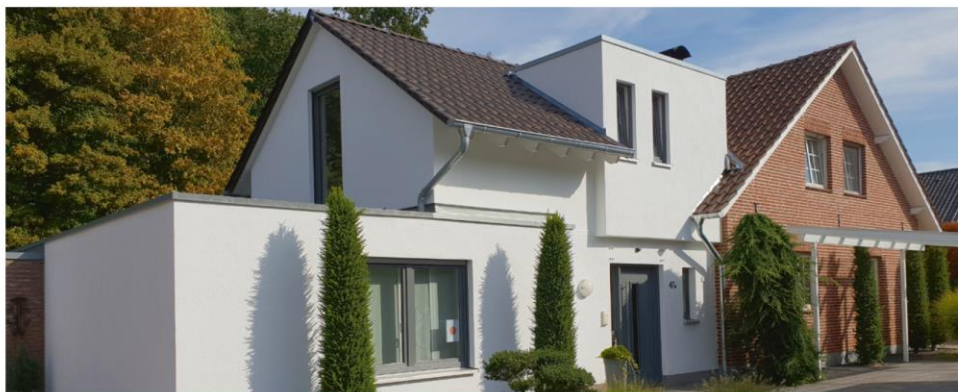
Öko-Bau - Aufstockung in Rhede
